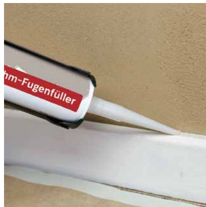
Fugenfüllung mit natur-weiß an einer Sockelleiste
