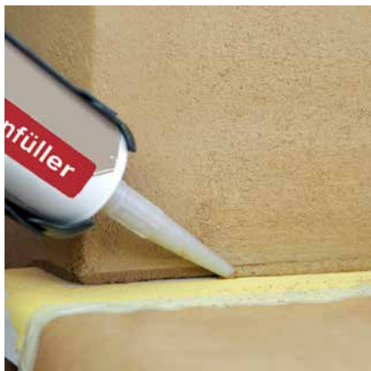
Fugenfüllung mit natur-braun an einer Fensterbank
